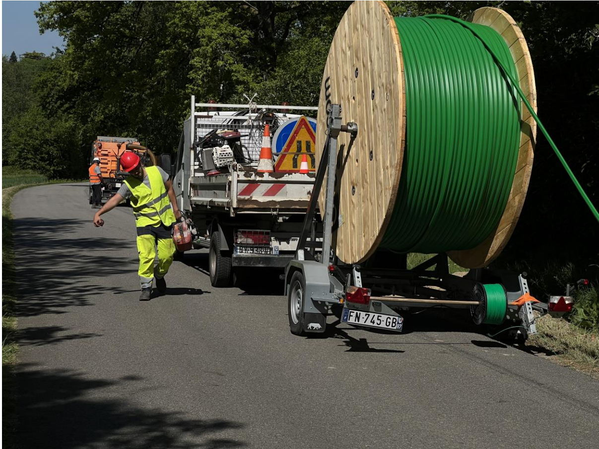
Figure 9 : Déroulement de câble fibre
