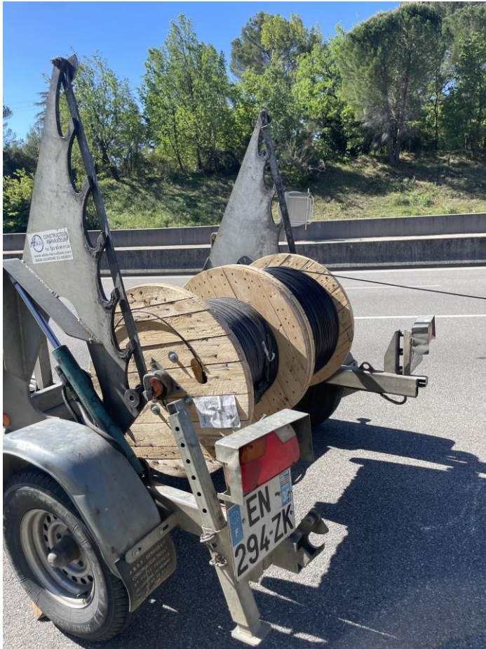
Figure 6 : Sur chantier (Projet Aix-Italie)
