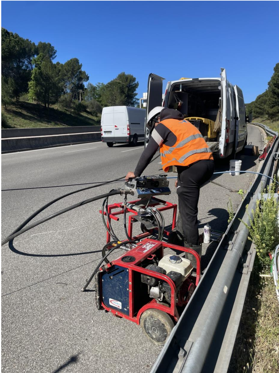
Figure 10 : Pousser du câble fibre dans les conduits (Projet Aix-Italie)
