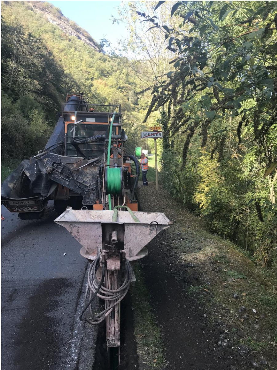
Figure 8 : Outils pour creuser les tranchées de fibre
