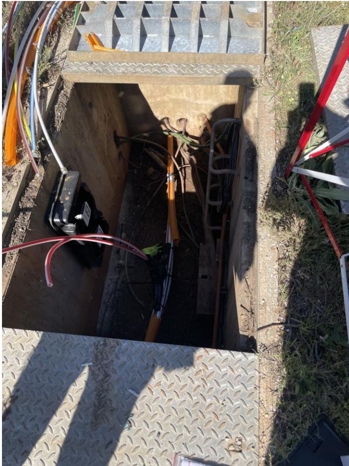
Figure 7 : Sur chantier (Projet Aix-Italie)
